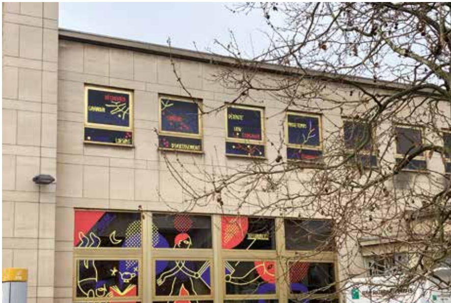
Façade Est de la bibliothèque
